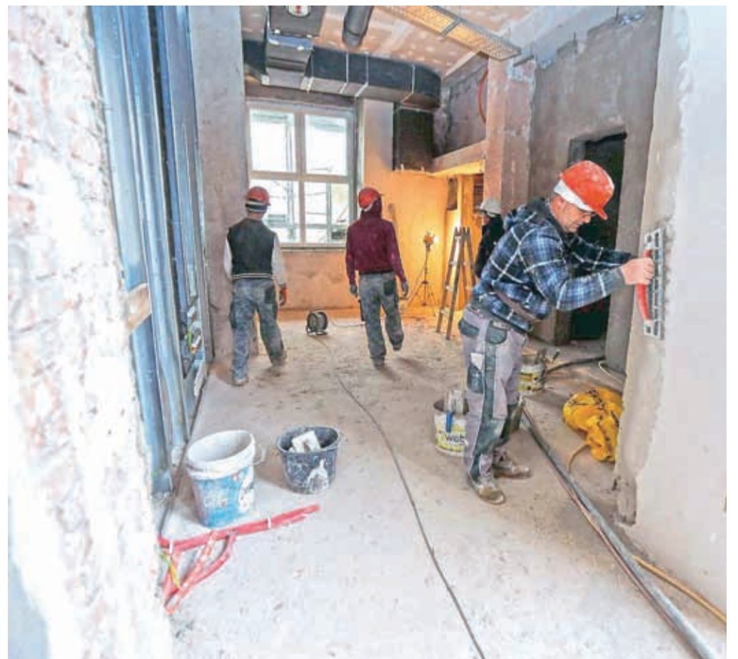
Prenova Podružnične šole Center na Komenskega ulici / FOTO: TINA DOKL
