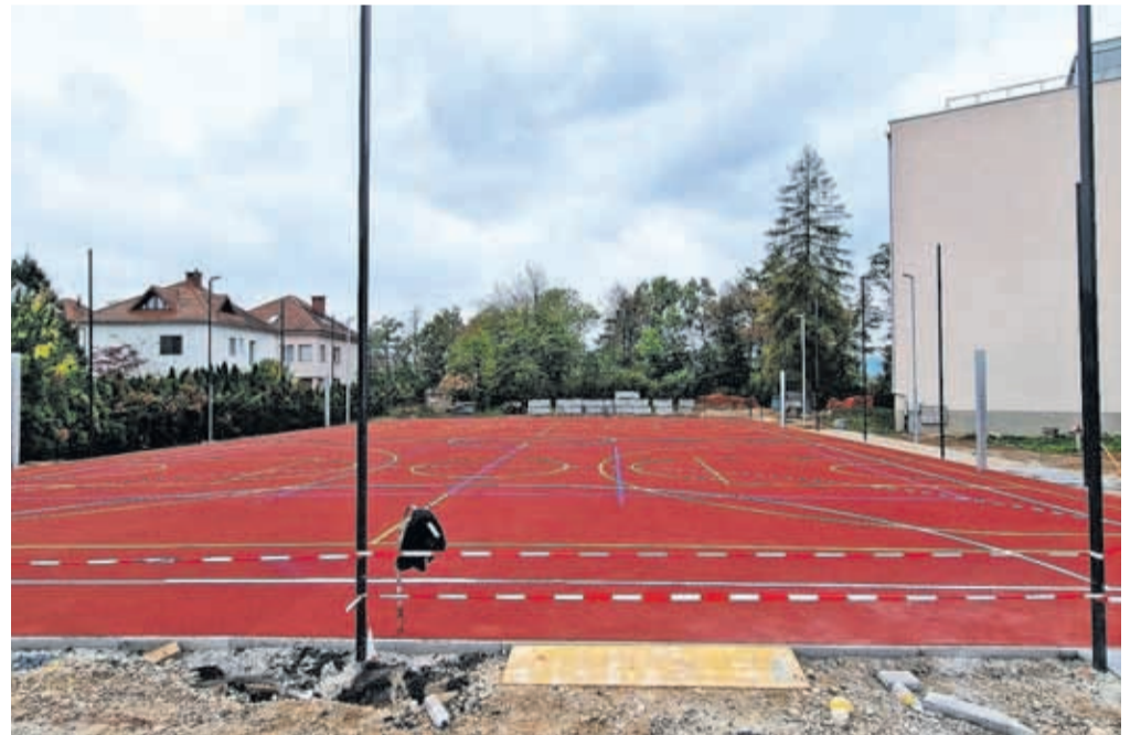
Zaključuje se gradnja prizidka pri OŠ Staneta Žagarja z novo telovadnico, šestimi učilnicami, večnamenskim prostorom in zunanjim igriščem. / Foto: MOK
