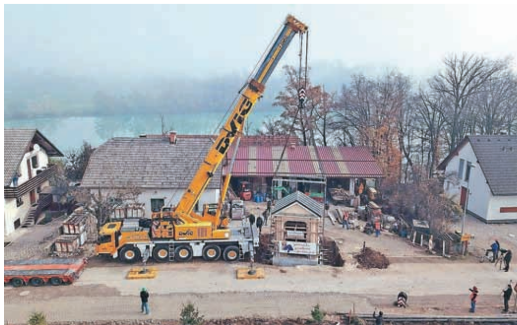
Prestavitev kapelice je bila zahtevna naloga, saj je to največji objekt, ki so ga na območju mestne občine Kranj doslej prestavili v enem kosu.
