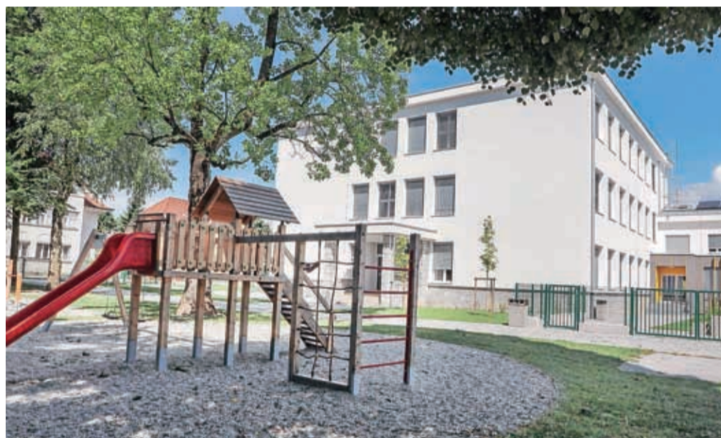
Nekdanja podružnična šola Simona Jenka – Center v novo šolsko leto vstopa kot samostojna Osnovna šola Janeza Puharja Kranj – Center. / FOTO: TINA DOKL
