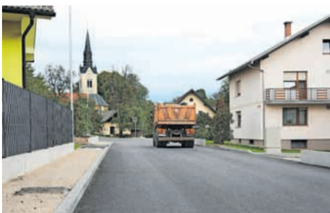
Fini sloj asfalta so položili, urediti morajo še pločnike in uvoze na dvorišča. / FOTO: GORAZD KAVČIČ
