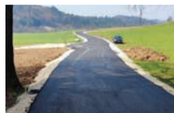
Cesta na Letenice – obnova 750 metrov dolgega odseka ceste
